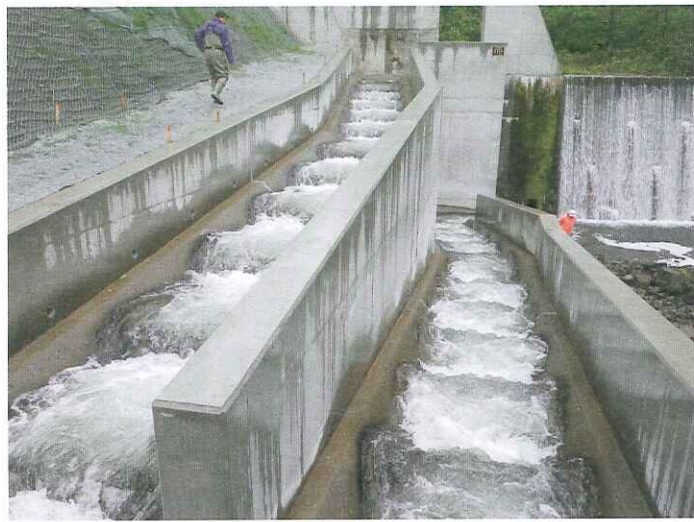
チエンベツ川(北海道羅臼町)の堰堤に設置された折り返し式提案魚道(写真提供:安田陽一氏)
